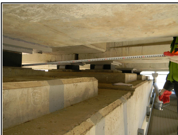
내 용 받침 연단거리 측정
