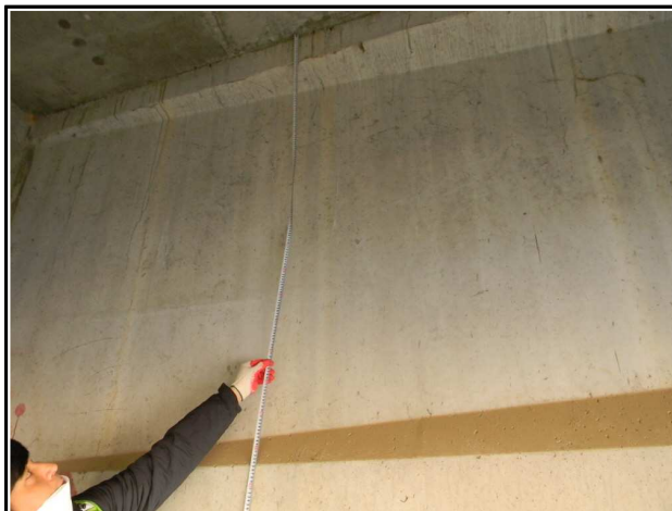
내 용 거더 제원조사 현황
