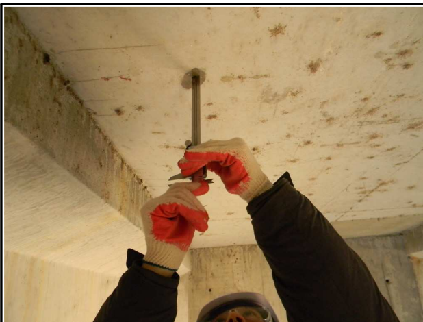
내 용 탄산화 측정 현황
