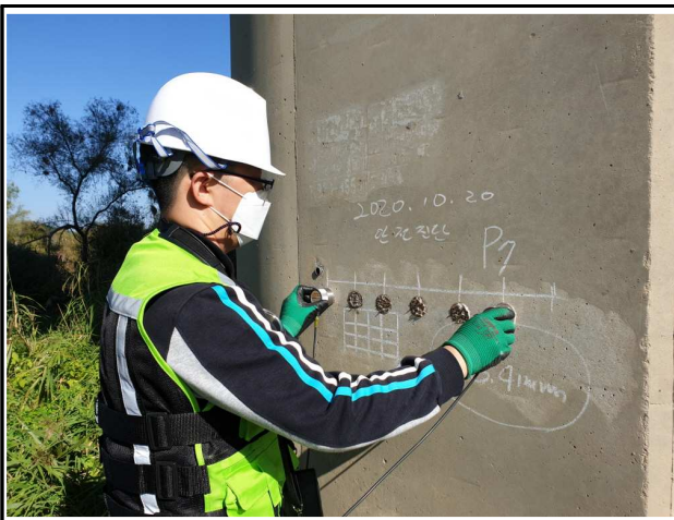
내 용 초음파속도법에 의한 콘크리트 강도조사 현황
