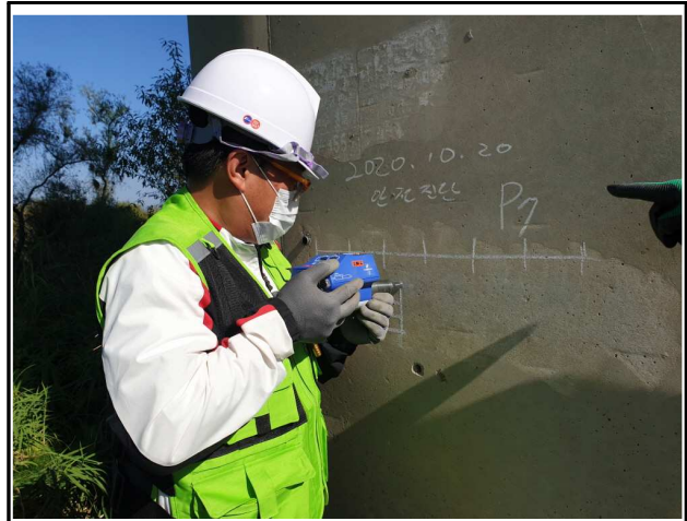
내 용 반발경도법을 이용한 압축강도 시험
