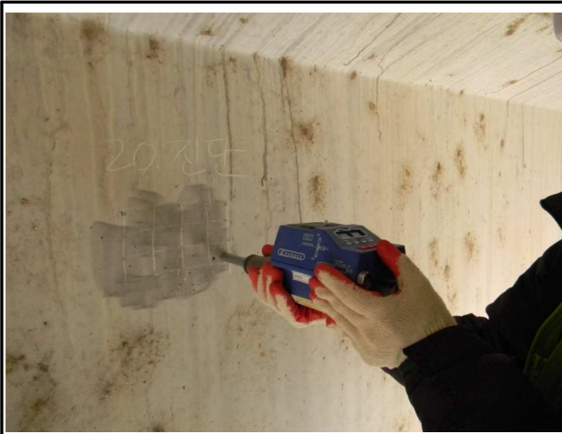
내 용 반발경도법을 이용한 압축강도 시험
