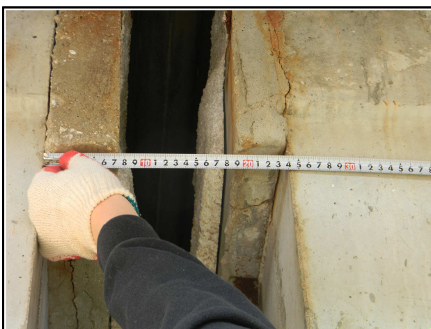
내 용 슬래브하면 신축유간 측정
