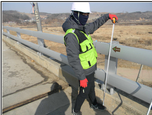
내 용 방호벽 제원조사 현황
